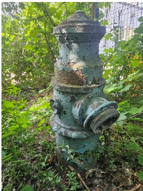
Ryc. 39 Istniejący hydrant do remontu
