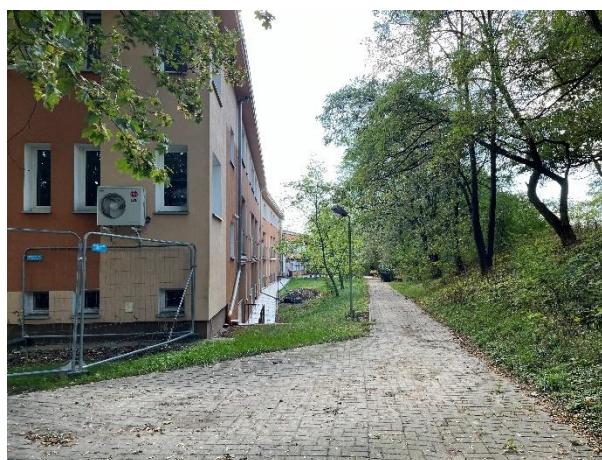
Ryc. 2 Widok na ścieżkę przy DPS
